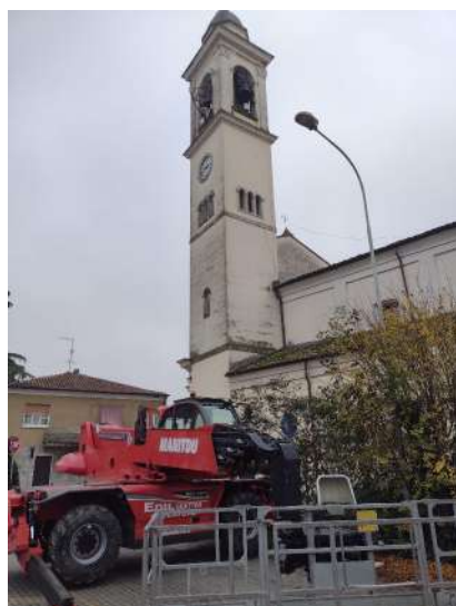
Durante i lavori
